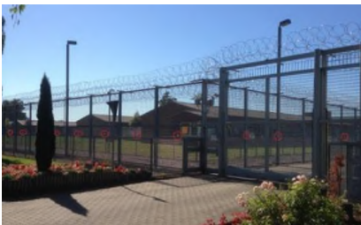
Justizvollzugsanstalt (JVA) – Perimeterschutz ca. 1.600 m
