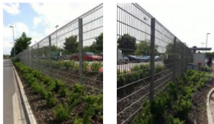
Pharmaindustrie – Perimeterschutz ca. 2.200 m
