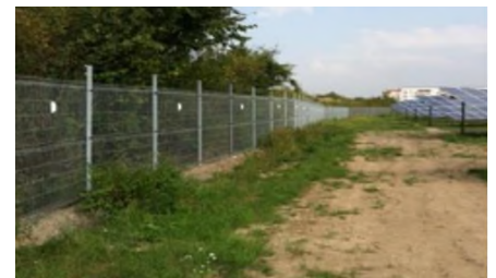
Solarpark – Perimeterschutz ca. 1.850 m
